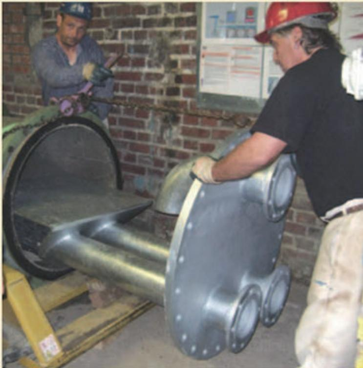
Abb. 3 Die Abbildung entstand beim Tausch des Flanschs vom Wasserschloss. Rechts unten wird das Grubenwasser entnommen. Das gebogene Rohr innen links dient der Rückführung des Grubenwassers.
